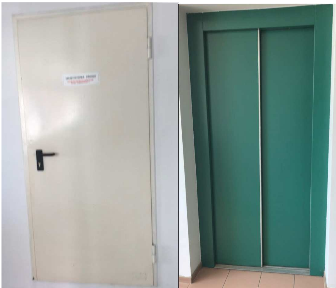
WIDOK DRZWI MASZYNOWNI I DRZWI DŹWIGU – drzwi do odmalowania
